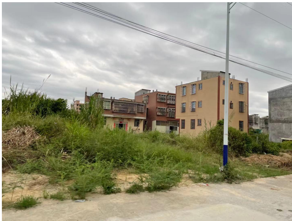
项目北侧自建楼 1
